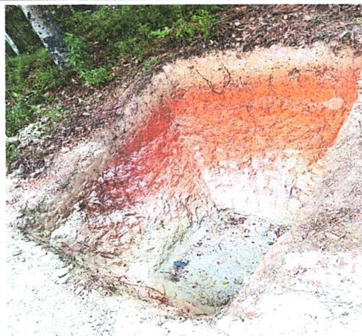
Foto 2: MEJORAMIENTO E INSTALACION DE SERVICIO SANITARIO
