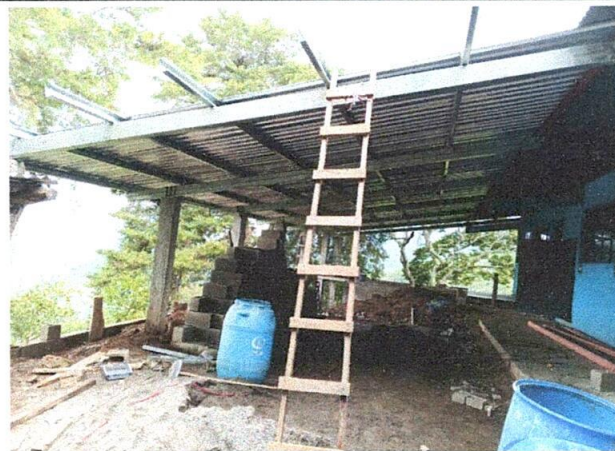
Foto 4: MEJORAMIENTO DE LOSA DE PATIO E INTALACION DE PORTICO CON LAMINA TROQUELADA CALIBRE VEINTISÉIS.
