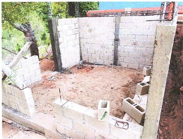
Foto 1: MEJORAMIENTO DE ÁREA DE PASILLO CON UNA CONTENCIÓN
